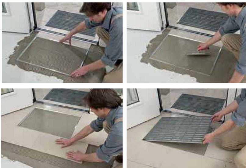
ACO jalamatisüsteem Indoor hoiab esiku puhtana. Eelis: vähem tööd, lisaks ka põrandakatte kindel kaitse. Paigaldamine on lihtne, paigaldatakse otse märga plaadisegusse.
