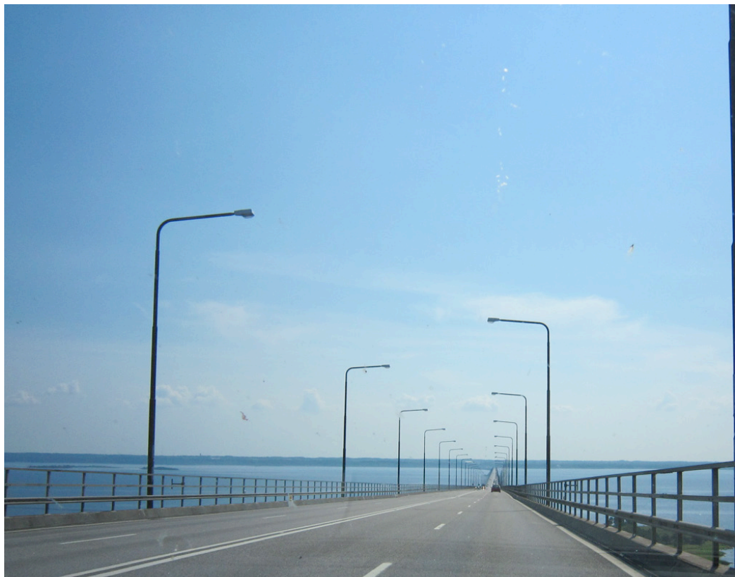
Säker avvattning håller vägbanan fri från vatten
