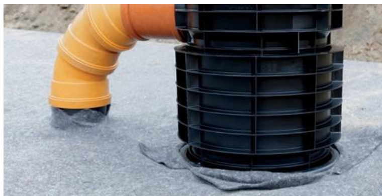
Geotekstiili lõigatakse ava ning see paigaldatakse ümber toruadapteri
