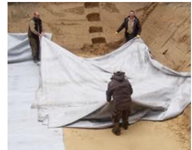
Peale kividevaba aluskihi tasandamist paigaldatakse filterkangas.
