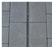
Tsingitud, rooste- vabast terasest või plastikust pilurest
