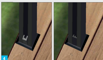
4 Vajutage või lööge ettevaatlikult kummihaamriga klambrid posti soonte põhja. Otsapostil vajutage pikk klamber otsasoonde.
