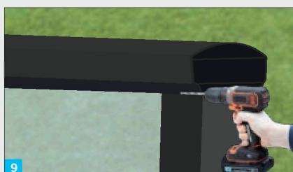
9 Lõigake käsipuu pikkus parajaks. Asetage käsipuu postioetstele ning puurige 3 mm ava väljastpoolt läbi käsipuu ja posti. Kinnitage käsipuu seejärel kaasasolevate kruvidega. Korra ke seda iga posti puhul.
