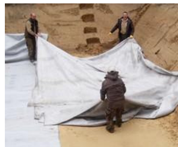
Peale kividevaba aluskihi tasandamist paigaldatakse filterkangas.
