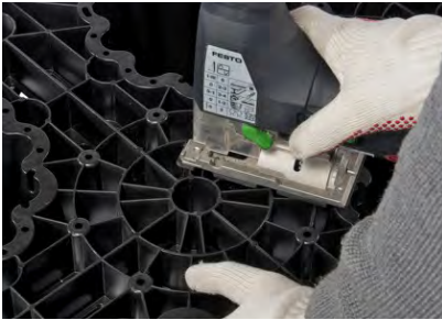
Peruselementin yläpintaan tehdään tarvittaessa merkattuun kohtaan tuuletus-/tarkastusputkea varten reikä.
