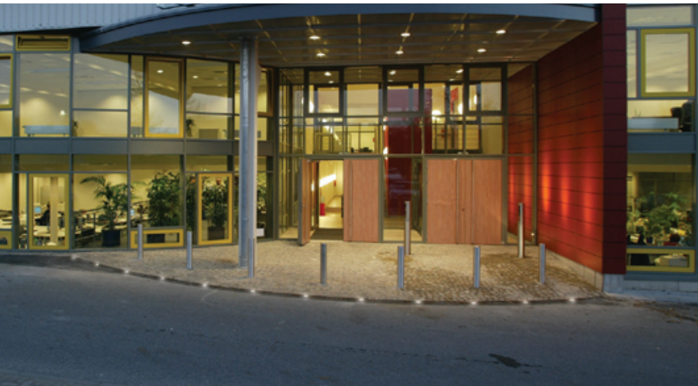
ACO DRAIN® Mobilcom-yrityksen sisäänkäynnin edessä Búdelsdorfissa, Saksassa.
